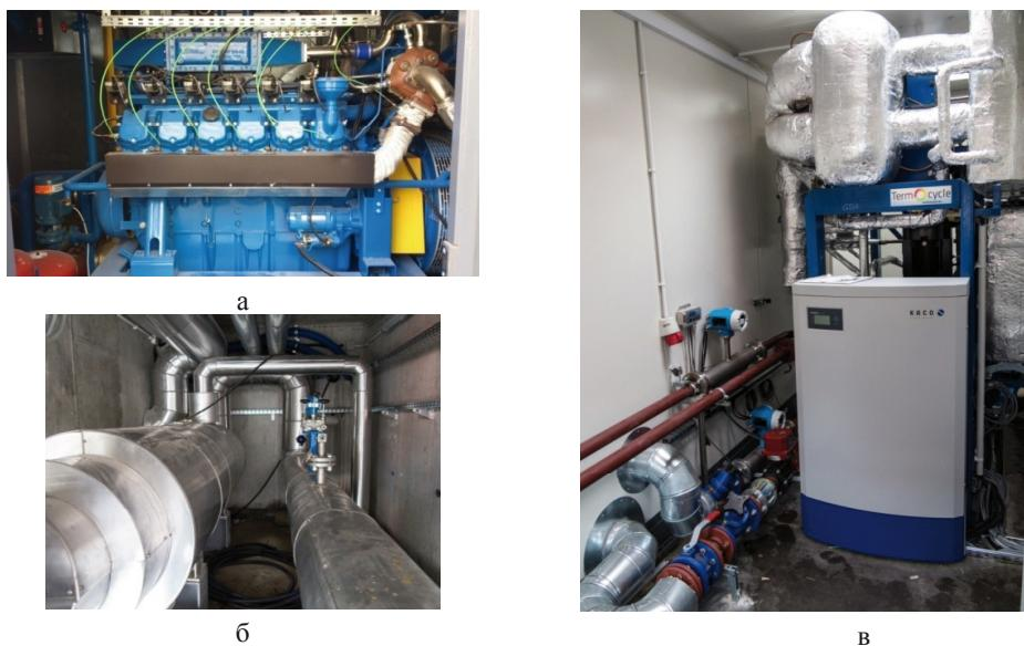
Рис. 3. Газопаровая система ORC в IMP PAN: ДВС MAN (а), котел-утилизатор (б) и ORC установка мощностью 40 кВт с расширителем (в)
