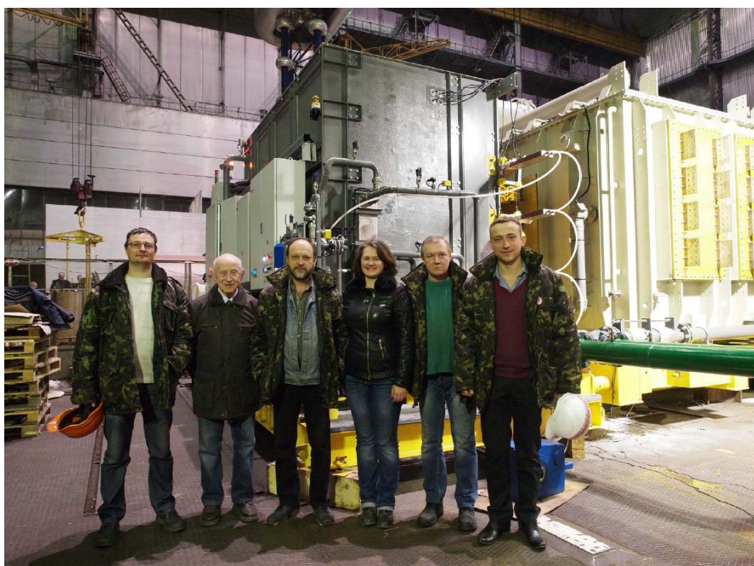
Фото 9. Группа испытателей ВИТ на фоне преобразовательного трансформатора ТЦНПУД 63000/10 для питания преобразователя 180 кА печей графитизации
